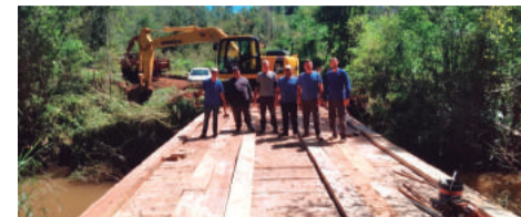
Uma das pontes reconstruídas
